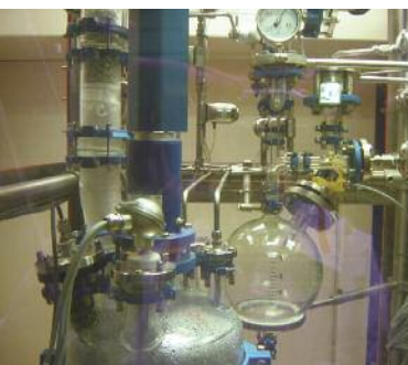
Hazardous waste treatment plant Anlage zur Sondermüllbehandlung
